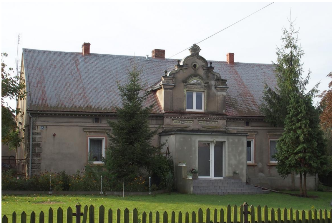
Widok budynku od północy
