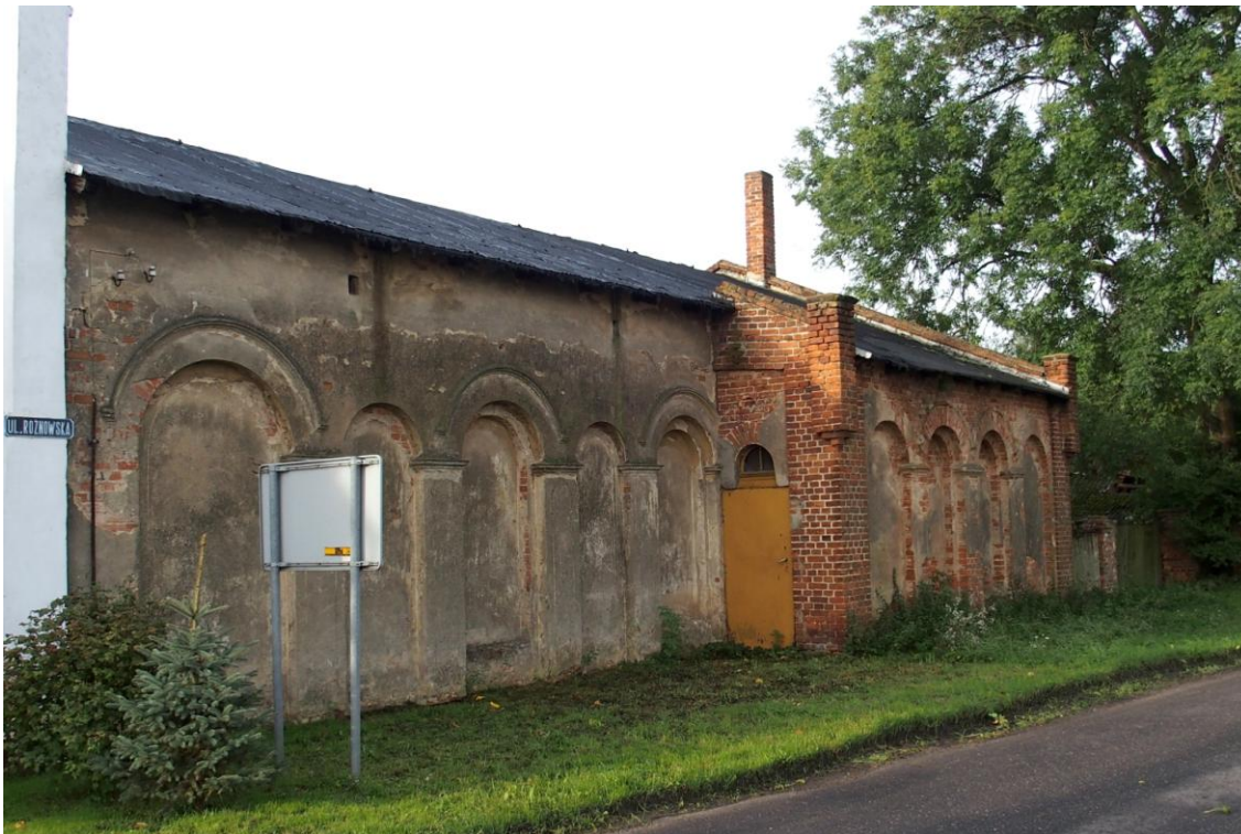
Widok budynku od północnego - wschodu
