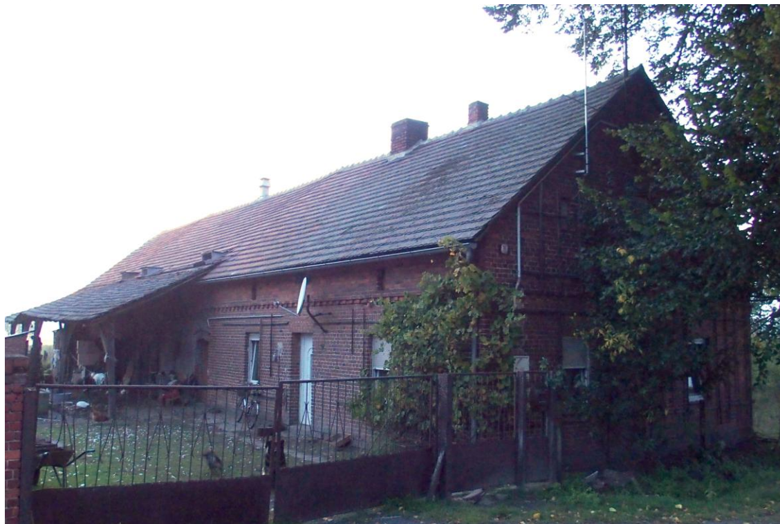
Widok budynku od południowego - wschodu
