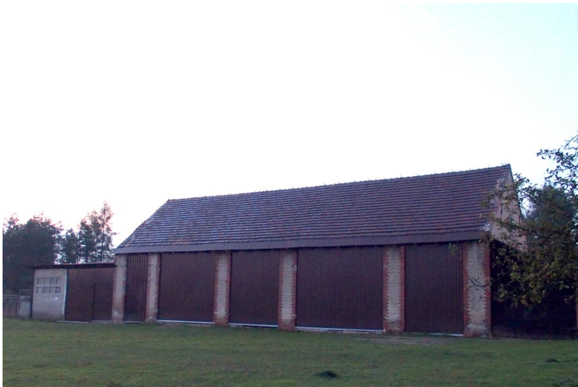
Widok budynku od wschodu
